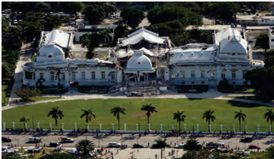
Imagen 17.1 Destrucciones provocadas por sismos 4
